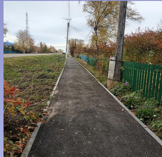
Ремонт пешеходного тротуара по ул. Советская в с. Большое Игнатово, 510 м.
