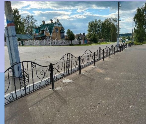
Установка ограждений (центральная площадь)
